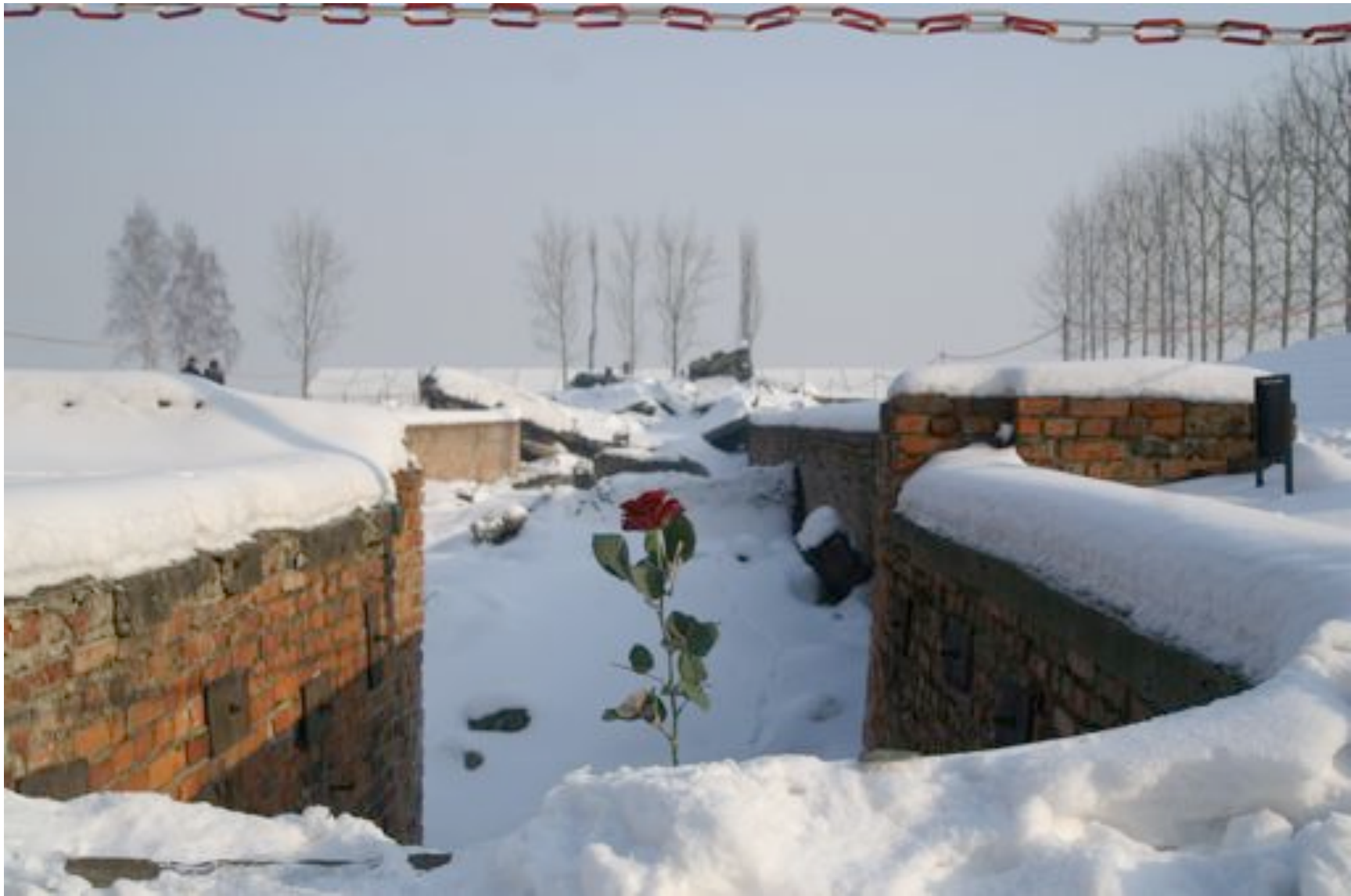
12 - les restes des chambres à gaz détruites par les nazis
